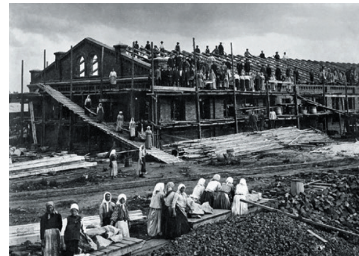
Строительство кузницы на заводе «Русский Рено» в Рыбинске
